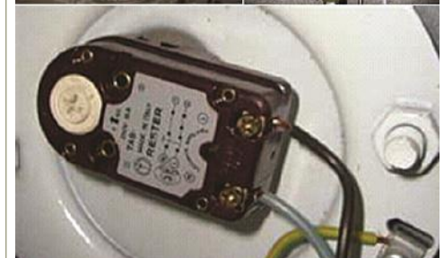
Ballon ECS et tuyaux de distribution calorifugés, en bas : thermostat de réglage de la température de l'ECS
