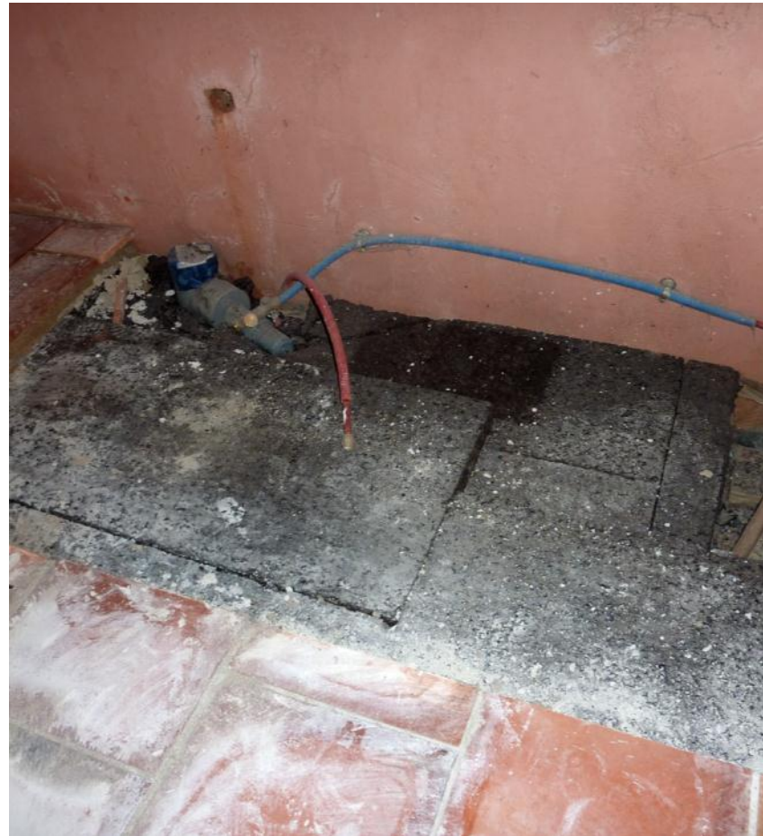
Isolation sur dalle en liège
