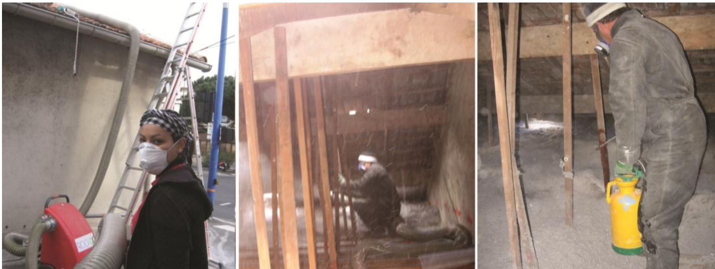
Après insufflation, la projection d'eau est recommandée pour « croûter » la ouate afin d'assurer sa stabilité dans les combles.
