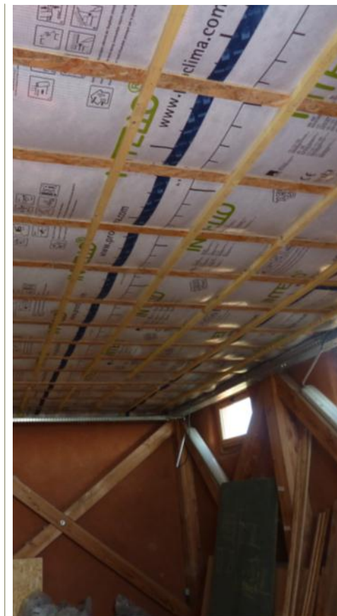
Isolation sous dalle par insufflation de ouate dans un caisson confiné.
