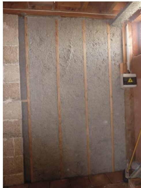
Isolation murale avec de la ouate de cellulose projetée humide
