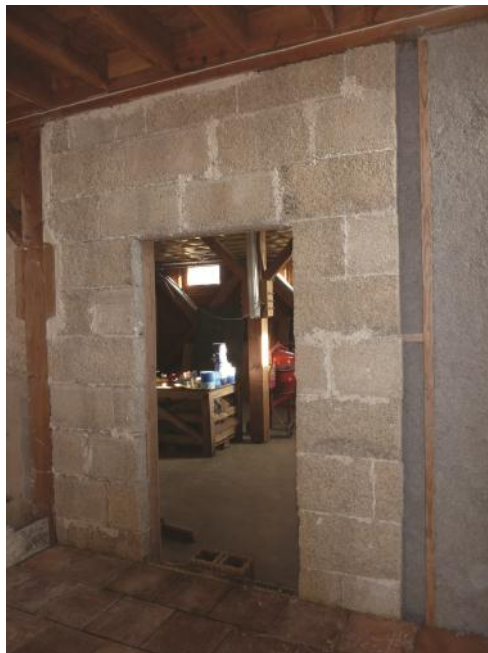
Isolation murale avec des briques de chanvre
