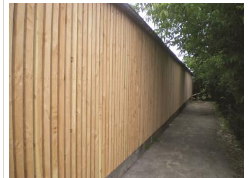
Isolation thermique par l'extérieur, finition bardage bois
