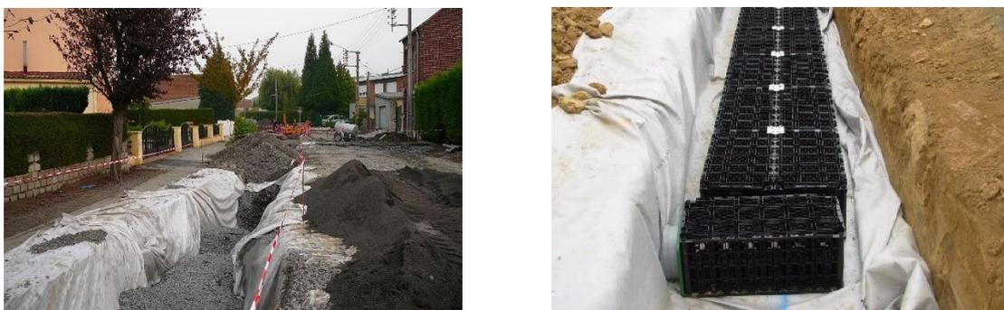
Figure 7 : Exemples de réalisation de tranchées d'infiltration [33]
