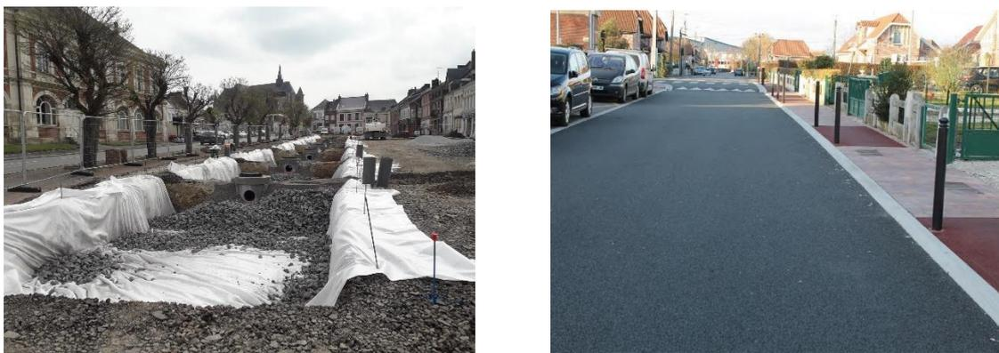
Figure 6 : Chaussée à structure réservoir [33]
