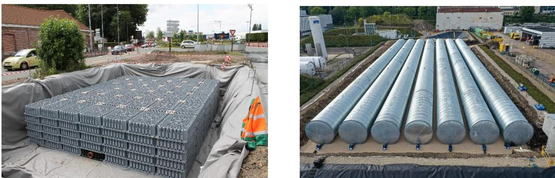
Figure 8 : Exemples de réalisation de bassins enterrés [33]
