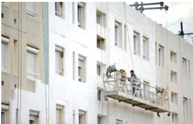
Le ravalement de façade est souvent un moment propice pour entreprendre également une isolation par l'extérieur.
