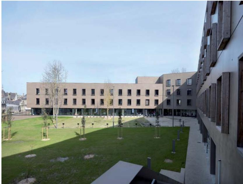
La conception des bâtiments a permis d'atteindre des consommations énergétiques inférieures de 30 % aux consommations maximales réglementaires, grâce à une attention particulière portée sur la conception architecturale (compacité, inertie, isolation par l'extérieur, rupteurs thermiques, éclairage naturel optimal, protections solaires adaptées...) et sur la performance des équipements techniques (surtout le chauffage et la climatisation).
