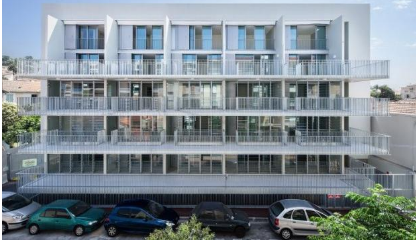
BBC Effinergie rénovation – Logements sociaux Antoine Brun – Cannes La Bocca MO : Office public de l'Habitat de Cannes et de la Rive Droite du Var Architectes : CAB Architectes - @Aldo Amoreti
